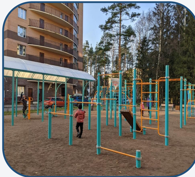
Устройство спортивной площадки в районе ул. Молодцова д.1
